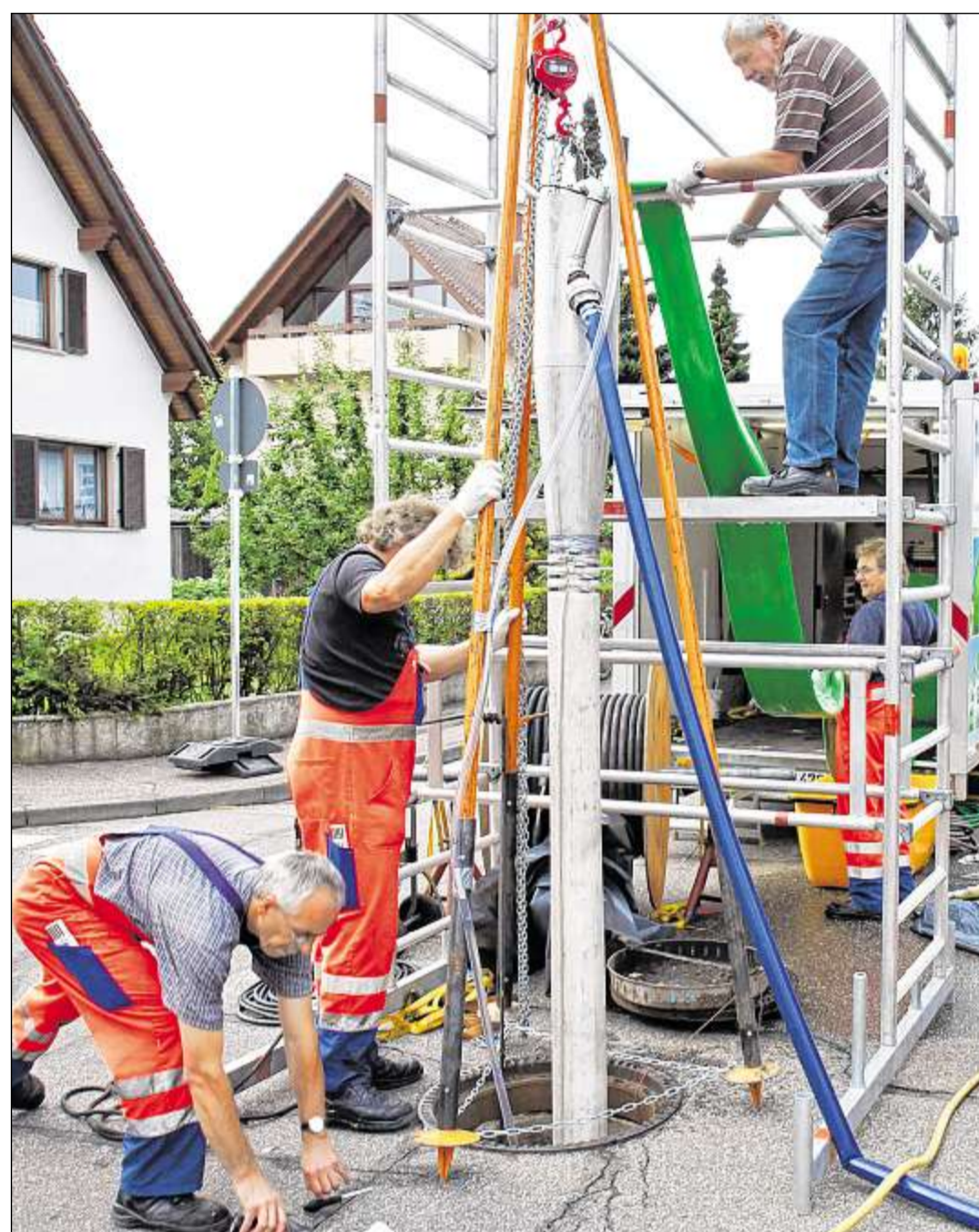
KANALSANIERUNG OHNE BAGGER: Mit einem Kunststoffrohr und Harz werden derzeit defekte Leitungen von innen ausgekleidet. Foto: Schneider
